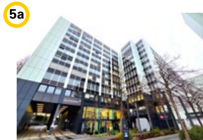
5a Außenstelle Giesing Balanstraße 55
